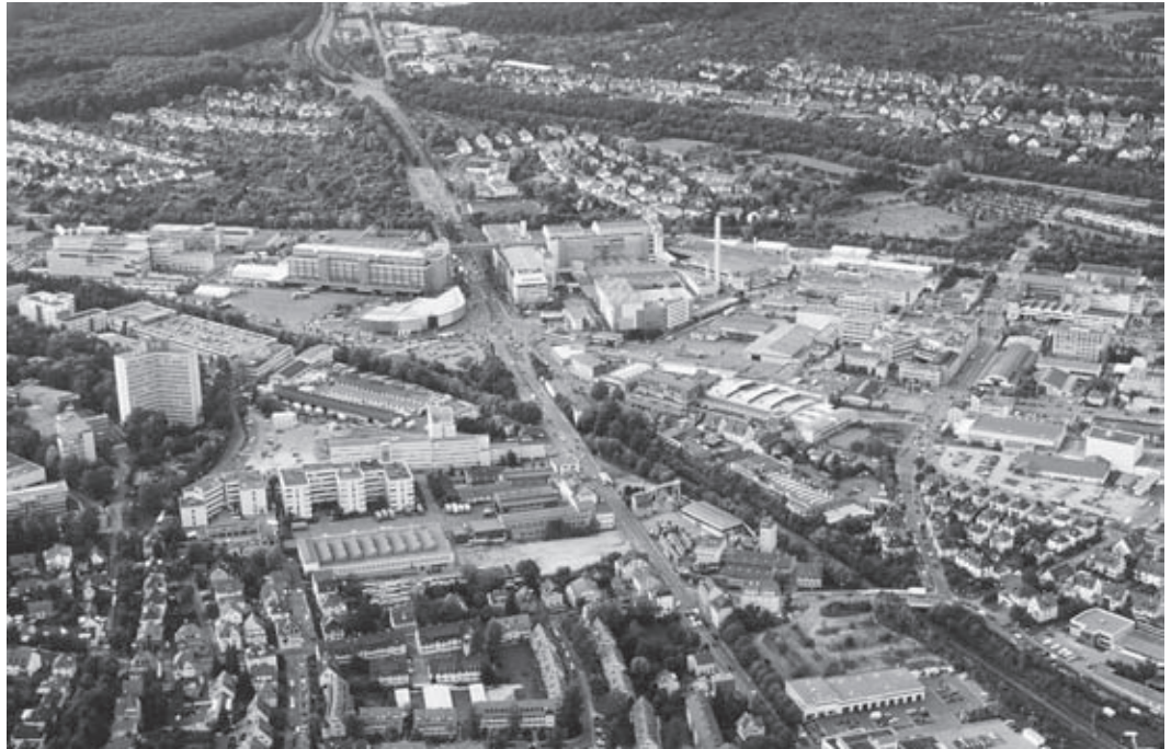
Abb. 6: Luftbild Gewerbegebiet Zuffenhausen. (Quelle: Ute Schmidt-Contag, Landeshauptstadt Stuttgart, Amt für Stadtplanung und Stadterneuerung)
