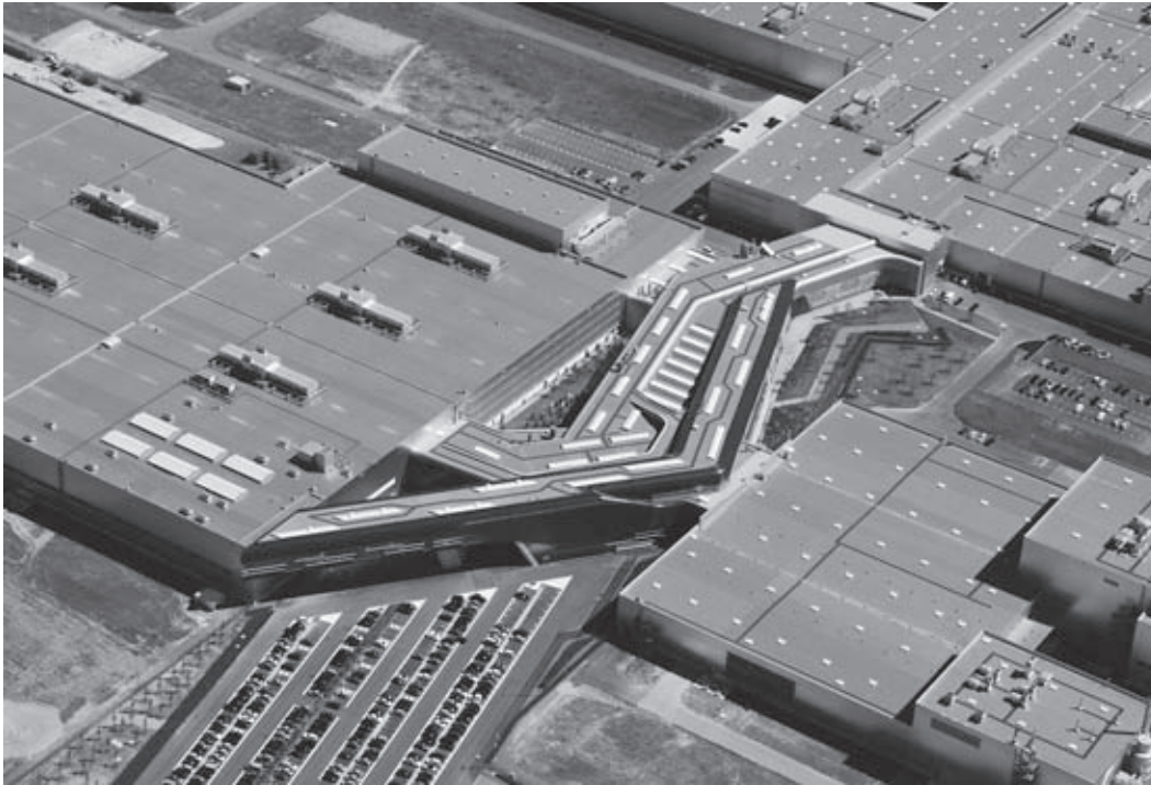
Abb.8: Zentralgebäude des neuen BMW-Werks nach dem Entwurf von Zaha Hadid. (Quelle: BMW AG, Martin Klindtworth)
