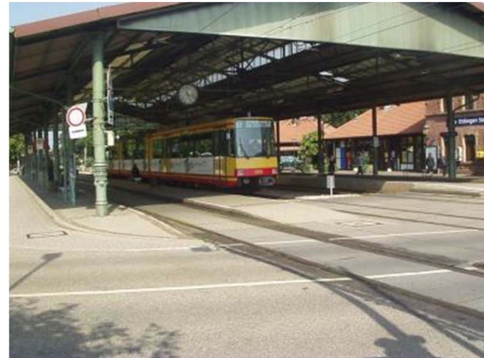
Bahnhof Ettlingen Stadt
